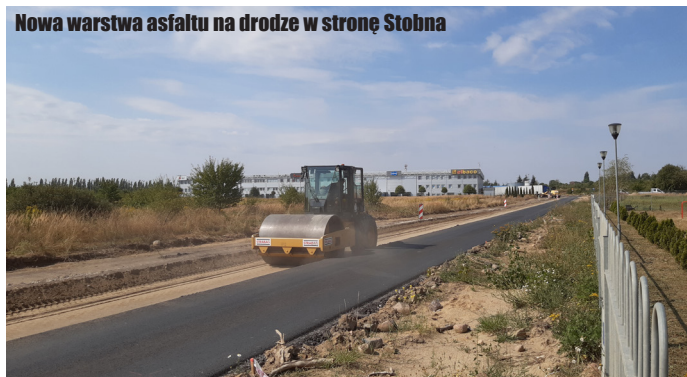
Nowa warstwa asfaltu na drodze w stronę Stobna
