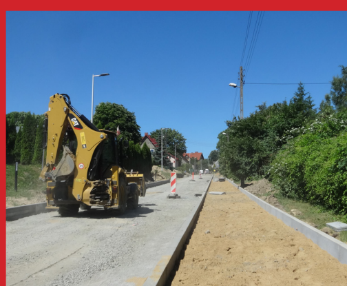
2018 - Przebudowa drogi gminnej w Moczylach wraz z kanalizacją deszczową
