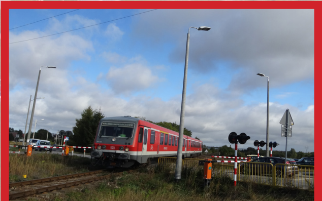
2018 - Działania na rzecz budowy rogatek na dwóch przejazdach kolejowych w Warzymicach
