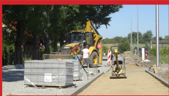
2018 - Przebudowa drogi gminnej w Karwowie
