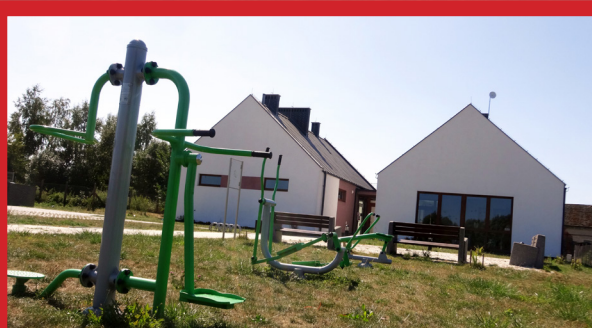
2015 - Budowa świetlicy wiejskiej w Barnisławiu
