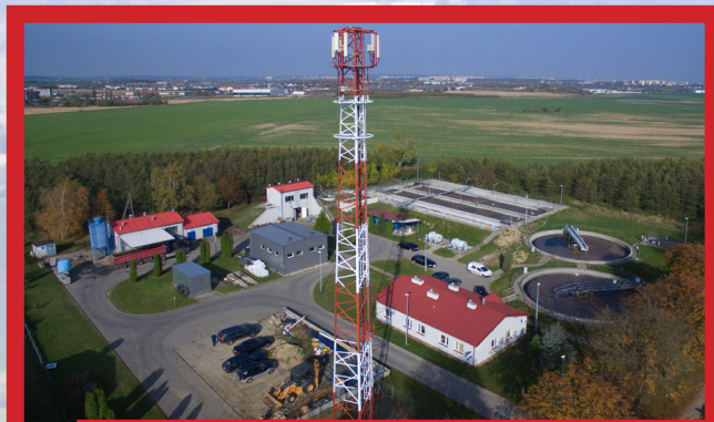
2015 - Rozbudowa oczyszczalni ścieków w Przeclawiu
