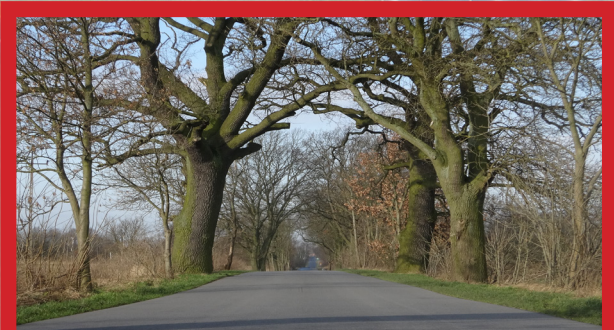
2015 - Budowa drogi gminnej Przecław – Kurów
