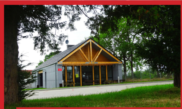
2016 - Budowa świetlicy wiejskiej w Kamieńcu
