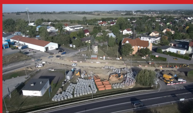
2018 - Przebudowa drogi powiatowej w Przeclawiu, od skate parku w stronę przejazdu kolejowego, wkład Gminy Kolbaskowo - 920 tys. zł
