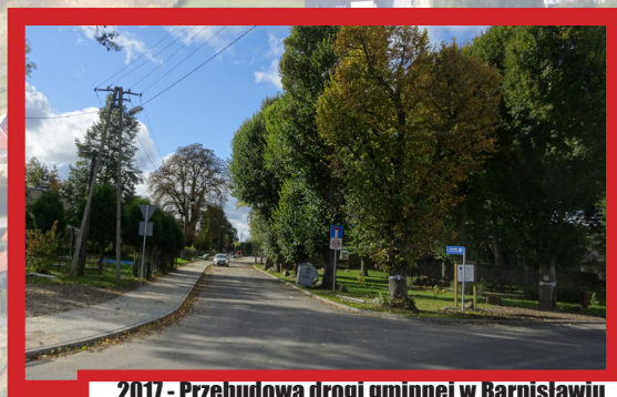
2017 - Przebudowa drogi gminnej w Barnisławiu wraz z kanalizacją deszczową
