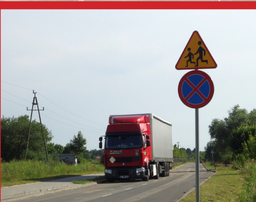
2016 - Budowa drogi w Przecławiu do obsługi terenów projektowanej zabudowy produkcyjnej i usługowej (m.in. do domu kultury), wraz z kanalizacją deszczową
