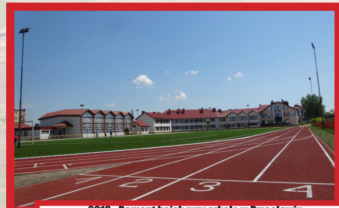
2018 - Remont boisk przy szkole w Przeclawiu
