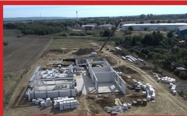
2018 - Budowa domu kultury w Przeclawiu
