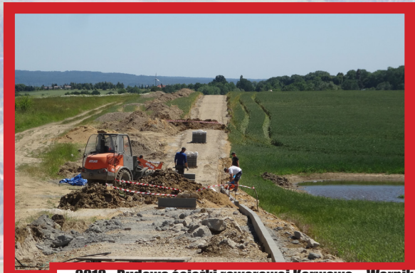
2018 - Budowa ścieżki rowerowej Karwowo – Warnik
