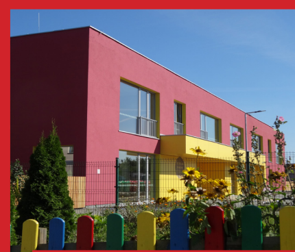
2017 - Budowa Przedszkola Publicznego i Żłobka w Przecławiu
