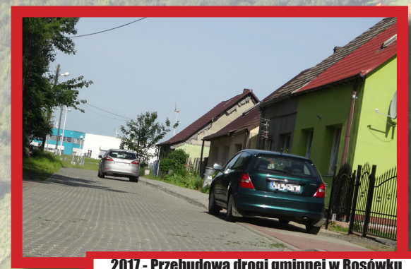
2017 - Przebudowa drogi gminnej w Rosówku
