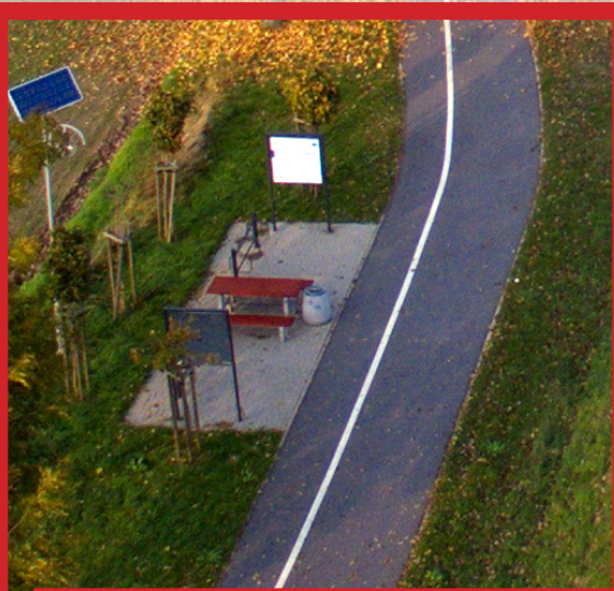
2015 - Budowa ścieżki pieszo-rowerowej z Przeclawia, przez Kołbaskowo, Rosówek, do granicy państwa
