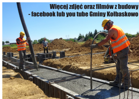
Prace rozpoczęły się 18 kwietnia
