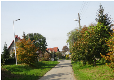
Inwestycję wykona spółka Met-Instal. Koniec prac planowany jest na 10 września. Koszt - 3,3 mln zł.
