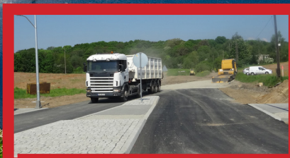
Budowa drogi łączącej drogę powiatową Smolećcin - Kolbaskowo z dk 13
