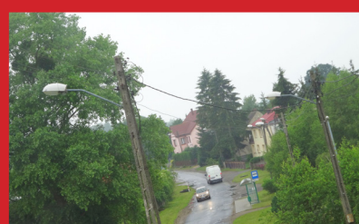
Budowa oświetlenia ulicznego w Stobnie do posesji Nr 13, 13a, 14a
