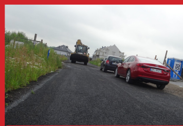
Budowa dróg w Warzymicach, ulice Turkusowa, Wrzosowa, Oliwkowa, Złota, wraz z kanalizacją i oświetleniem
