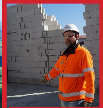
Budowa Przedszkola Publicznego w Przecławiu
