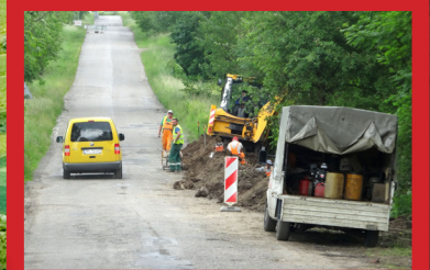
Budowa wodociągu z Siadło Dolnego do Siadła Górnego wraz z przyłączami
