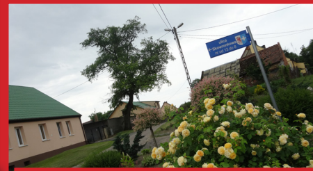
Budowa oświetlenia ulicznego w Kamieńcu przy ul. Pod lasem i Skowronkowej
