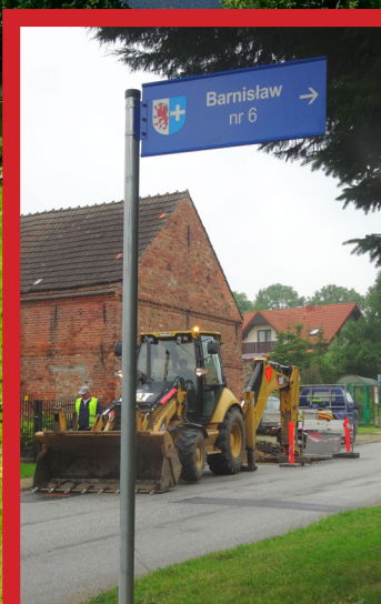
Przebudowa sieci wodociągowej w miejscowości Barnisław
