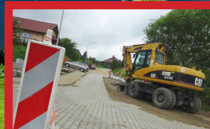
Przebudowa drogi wewnętrznej w miejscowości Siadło Dolne
