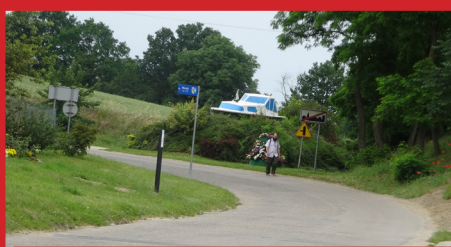
Przebudowa drogi gminnej Nr 195031Z w Moczyłach wraz kanalizacją deszczową
