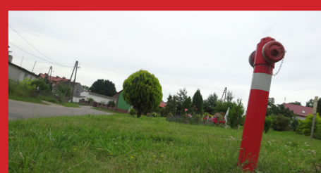
Przebudowa sieci wodociągowej w Moczyłach
