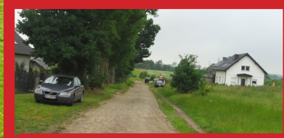
Przebudowa dróg w Karwowie i budowa ścieżki rowerowej Karwowo-Warnik
