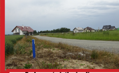
Budowa oświetlenia ulicznego w Kamieńcu przy ul. Chabrowej
