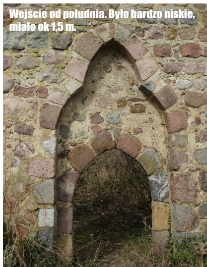
Elewacje ścian i szczytów wykonano z kwadr granitowych i głazów narzutowych.
